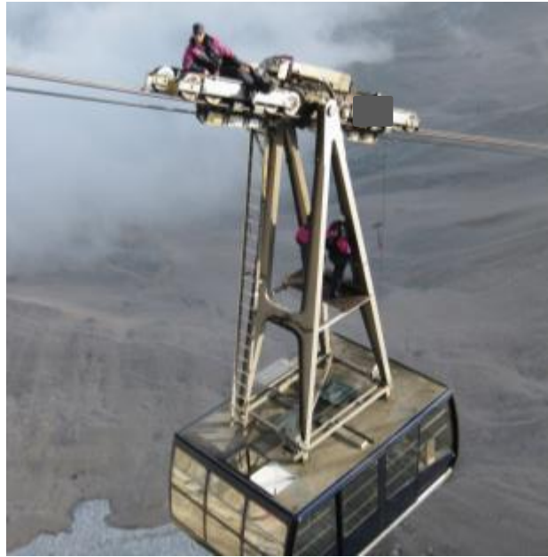
Abbildung 5.10: Visuelle Inspektion von Tragseilen auf einer Plattform und dem Laufwerk
