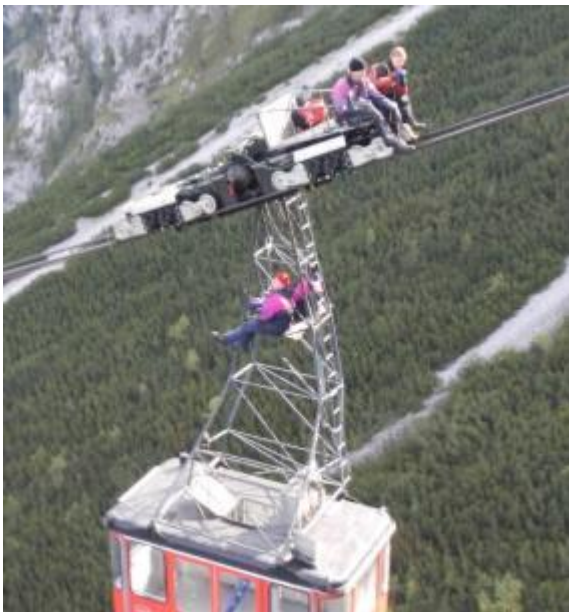
Abbildung 5.11: Visuelle Inspektion von Tragseilen mit Vorrichtung zum Sitzen und Liegen
