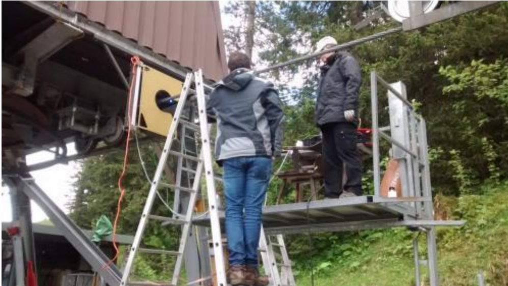
Abbildung 6.29: Arbeitsplatzbedingungen an der Anlage Längenfelder
