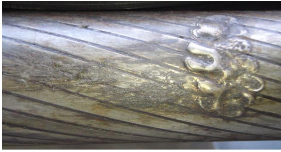
Abbildung 4.14: Einschlagstelle an Seilunterseite
