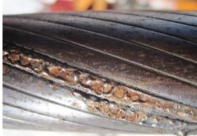
Abbildung 4.11: Blitzschaden an VVS
