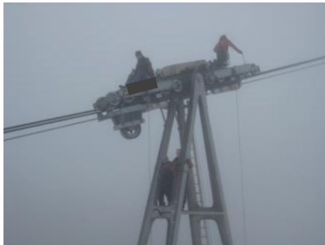
Abbildung 5.4: Nebel bei Tragseilinspektion
