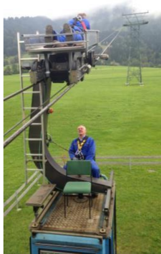
Abbildung 7.28: Visuelle Inspektion von Tragseilen an der Grüntenseilbahn
