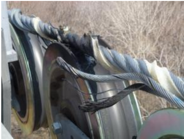
Abbildung 4.6: Schaden durch Stromfluss
