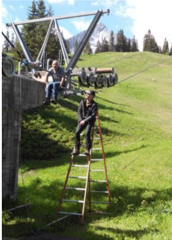
Abbildung 5.3: Visuelle Inspektion auf einer Leiter und einer kleinen Plattform
