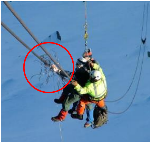
Abbildung 4.8: Tragseilschaden [9]
