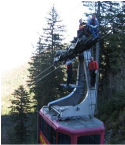
Abbildung 5.9: Visuelle Inspektion von Tragseilen auf der Leiter, einer Plattform, einem Sitz und dem Laufwerk
