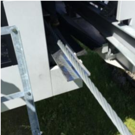
Abbildung 5.13: Spiegel an standardisierter Modulstation für Einseilumlaufbahnen (Blick von außerhalb der Station)
