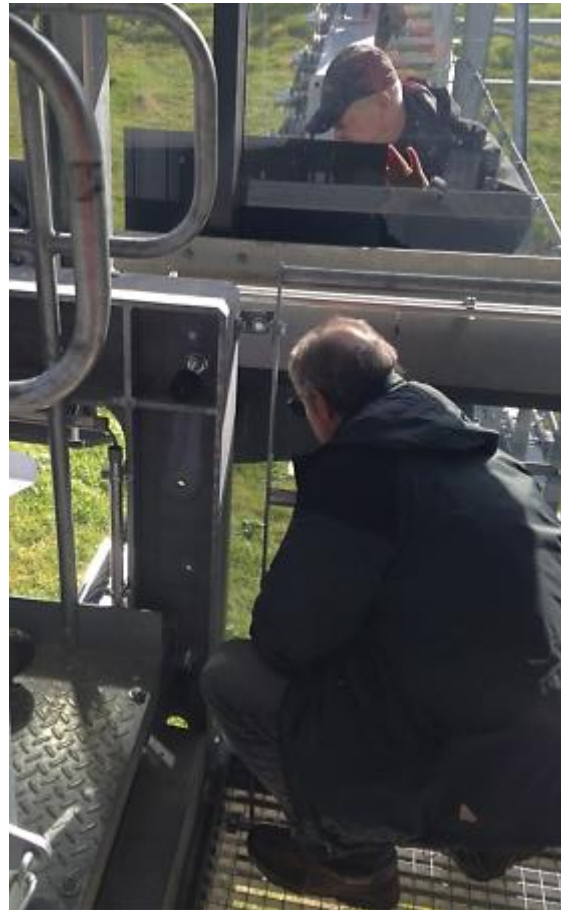
Abbildung 7.24: Anbringung des Sonnenschutzes
