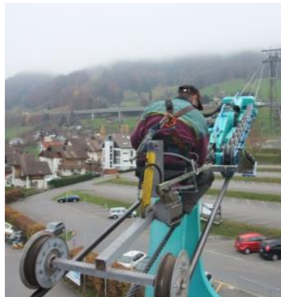
Abbildung 5.12: Visuelle Inspektion von Tragseilen mit Vorrichtung zum Sitzen
