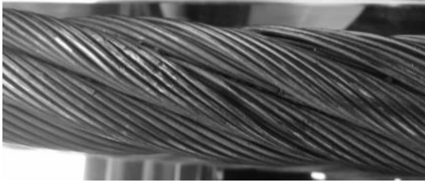
Abbildung 7.25 Schaden, der während der Inspektion zu finden war
